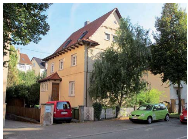
Ansicht des Wohnhauses von Nordwesten
