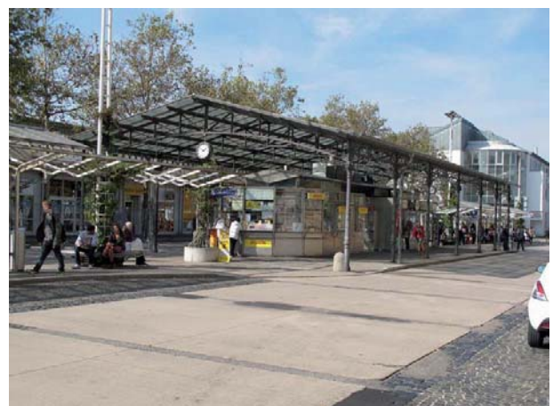
Ansicht der Wartehalle von Südosten
