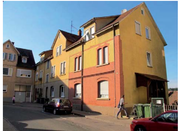
Ansicht des Reihenhauses von Südosten
