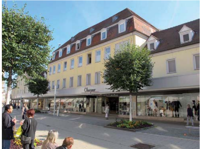
Ansicht des Wohn- und Geschäftshauses von Nordwesten
