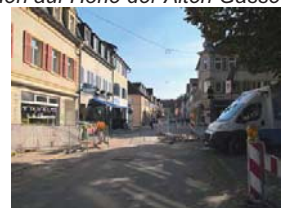
❷ Blick nach Süden bei Hausnr. 16
