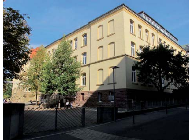
Ansicht des Schulhauses von Südwesten
