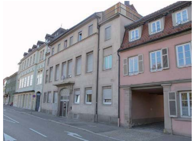
Ansicht des Mehrfamilienhauses von Nordosten
