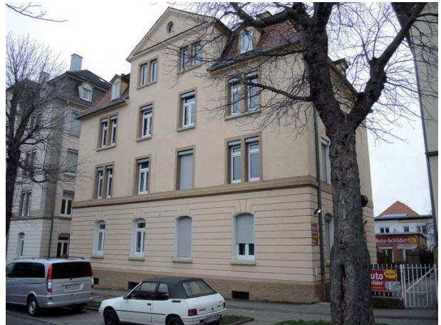
Ansicht des Mehrfamilienhauses von Südwesten
