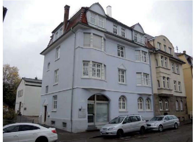
Ansicht des Mehrfamilienhauses von Nordosten
