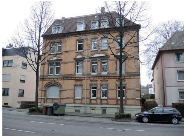
Ansicht des Mehrfamilienhauses von Norden
