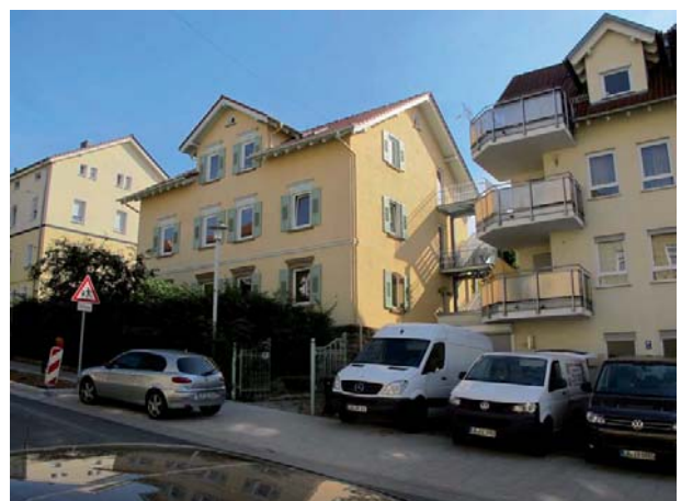
Ansicht des Wohnhauses von Nordwesten
