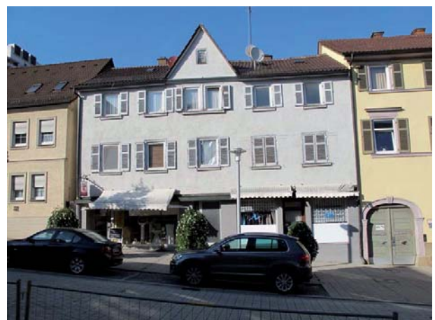
Ansicht des Wohn- und Geschäftshauses von Süden
