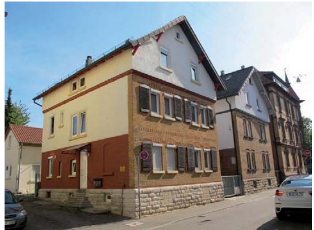
Ansicht des Wohnhauses von Nordwesten
