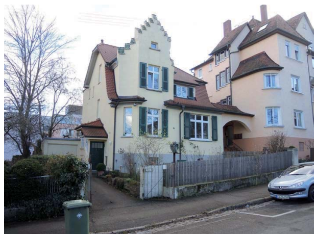
Ansicht des Wohnhauses von Nordwesten
