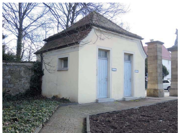
Ansicht des Toiletten- und Warthäuschens von Nordwesten
