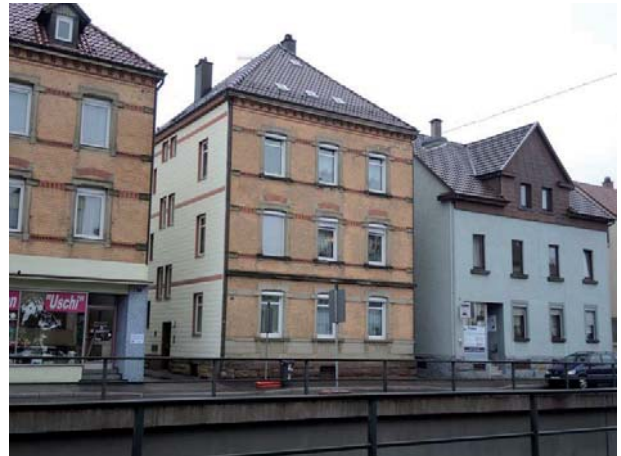
Ansicht des Mehrfamilienhauses von Nordosten
