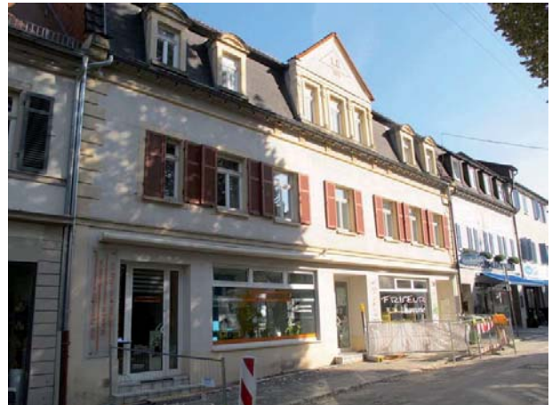
Ansicht des Wohn- und Geschäftshauses von Nordwesten
