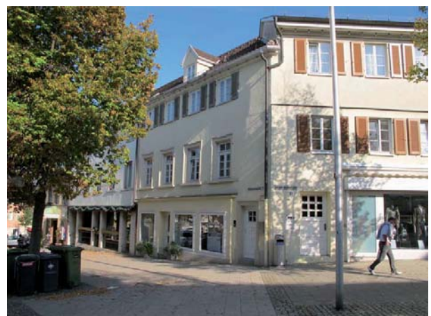
Ansicht des Wohn- und Geschäftshauses von Westen
