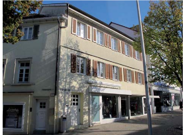
Ansicht des Wohn- und Geschäftshauses von Nordwesten
