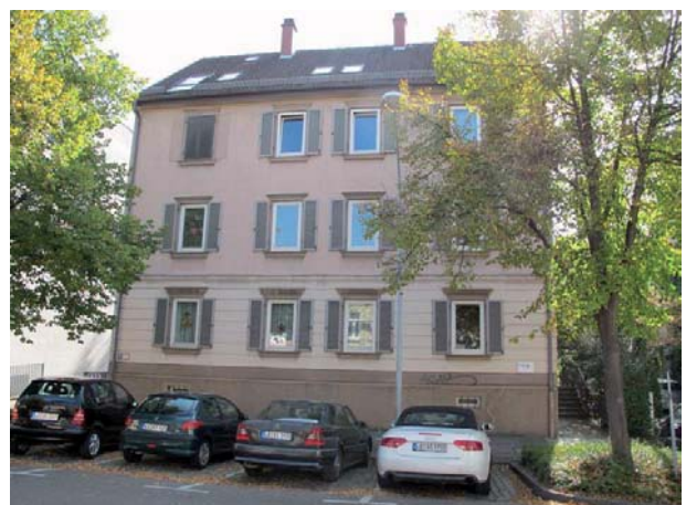
Ansicht des Mehrfamilienhauses von Norden
