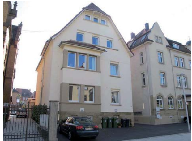
Ansicht des Mehrfamilienhauses von Nordosten
