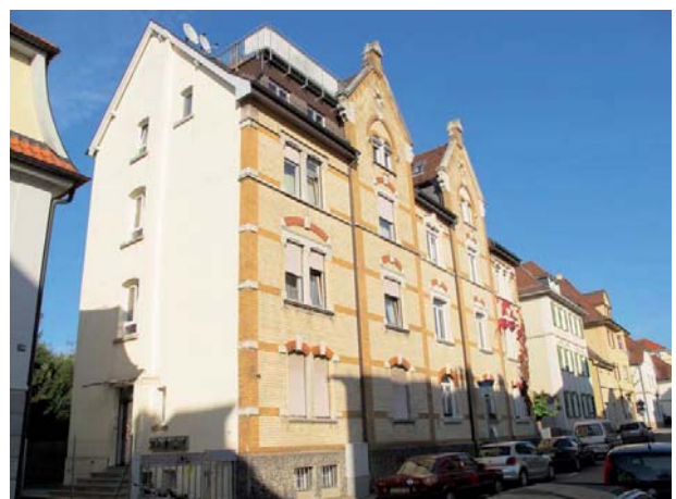
Ansicht des Mehrfamilienhauses von Südwesten
