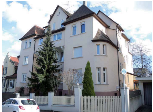
Ansicht des Mehrfamilienhauses von Südwesten
