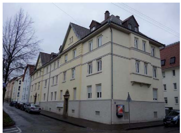
Ansicht des Mehrfamilienhauses von Nordosten
