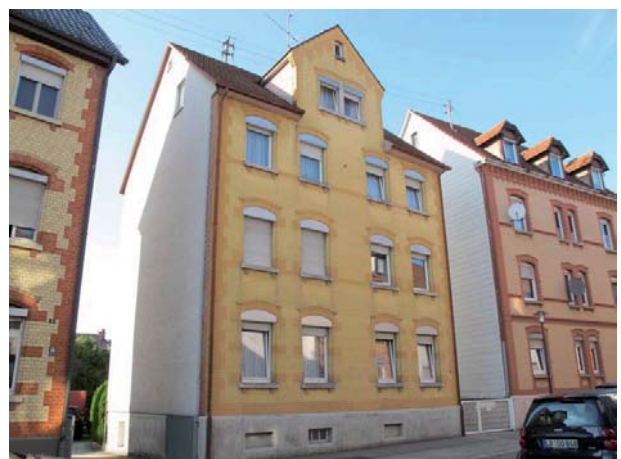
Ansicht des Mehrfamilienhauses von Südosten
