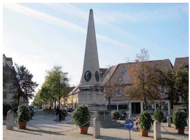
Ansicht des Obelisks von Südosten
