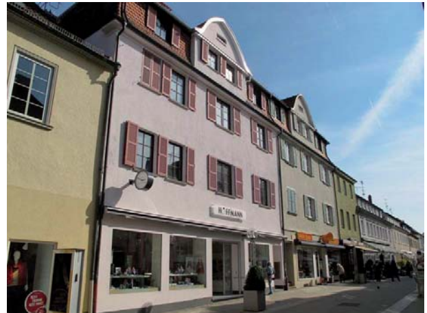
Ansicht des Wohn- und Geschäftshauses von Nordwesten
