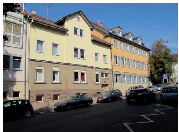
Ansicht des Mehrfamilienhauses von Südwesten
