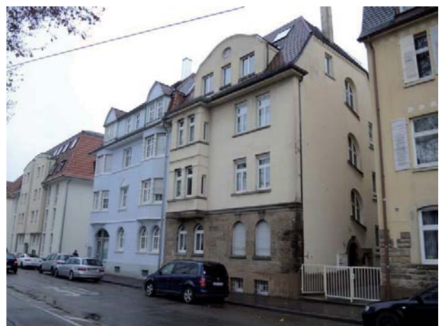
Ansicht des Mehrfamilienhauses von Nordwesten
