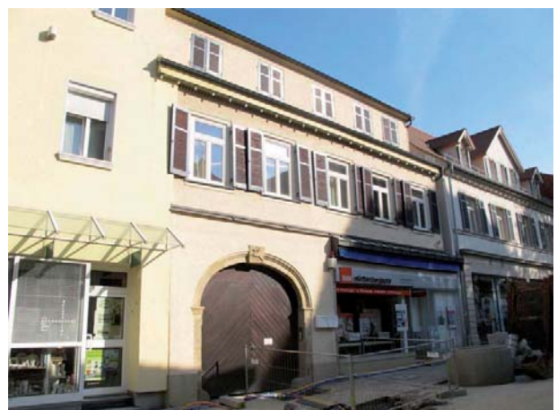
Ansicht des Wohn- und Geschäftshauses von Nordwesten
