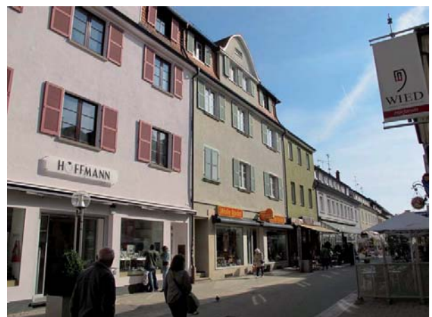
Ansicht des Wohn- und Geschäftshauses von Nordwesten
