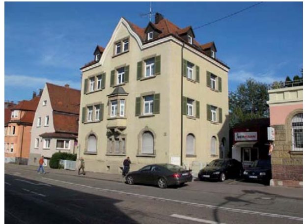
Ansicht des Mehrfamilienhauses von Südwesten
