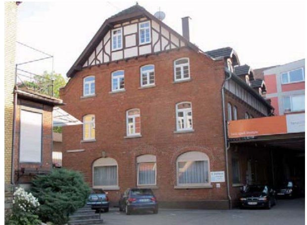
Ansicht der einstigen Fabrikhalle von Nordwesten
