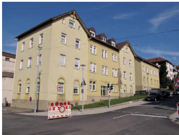
Ansicht des Mehrfamilienhauses von Südwesten
