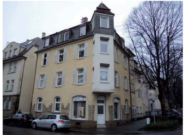
Ansicht des Wohn- und Geschäftshauses von Nordwesten
