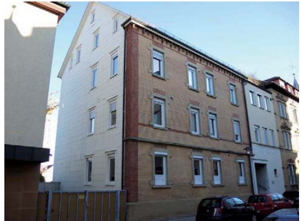
Ansicht des Mehrfamilienhauses von Südwesten
