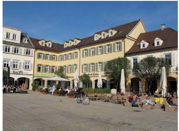
Ansicht des Wohn- und Geschäftshauses von Südwesten
