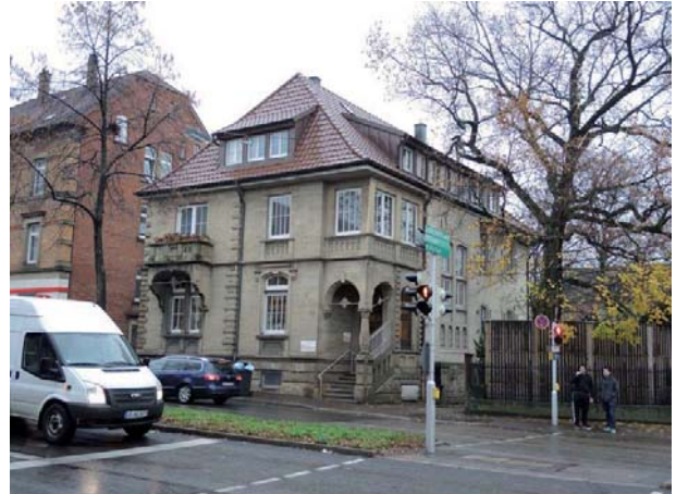
Ansicht des Wohn- und Geschäftshauses von Nordwesten
