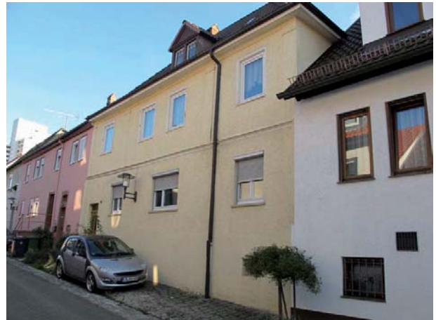
Ansicht des Wohnhauses von Nordwesten
