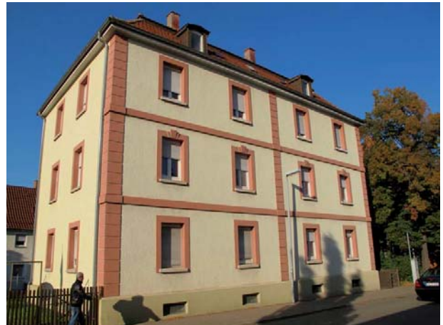
Ansicht des Mehrfamilienhauses von Südwesten
