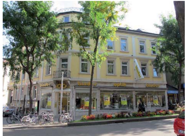
Ansicht des Wohn- und Geschäftshauses von Nordwesten
