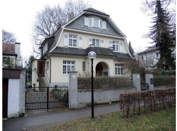
Ansicht des Wohnhauses von Nordwesten
