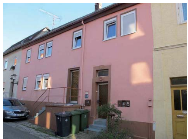
Ansicht des Wohnhauses von Nordwesten
