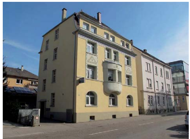
Ansicht des Mehrfamilienhauses von Nordwesten
