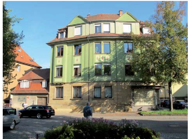
Ansicht des Wohn- und Geschäftshauses von Westen
