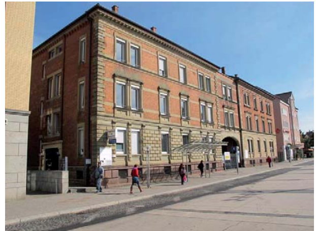
Ansicht des Wohn- und Geschäftshauses von Nordwesten
