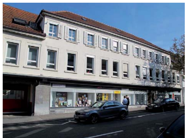
Ansicht des Wohn- und Geschäftshauses von Nordwesten
