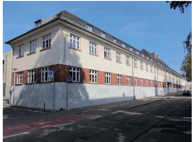
Ansicht des Gebäudes von Südwesten
