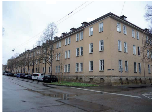
Ansicht der ehemaligen Kaserne von Südosten
