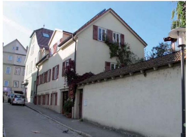
Ansicht des Wohnhauses von Südosten
