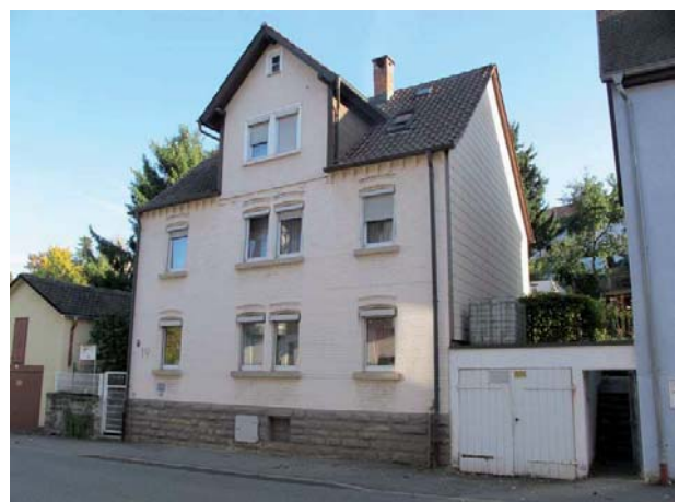
Ansicht des Wohnhauses von Nordwesten
