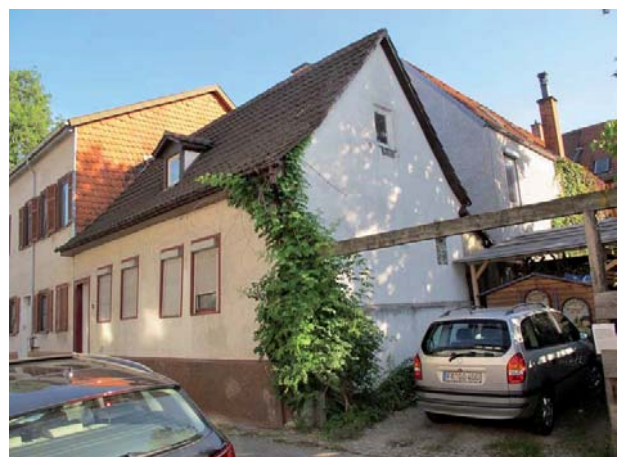
Ansicht des Wohnhauses von Nordwesten
