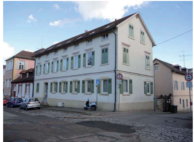
Ansicht des Mehrfamilienhauses von Südwesten
