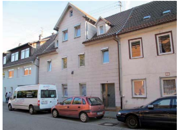
Ansicht des Wohnhauses von Nordwesten
