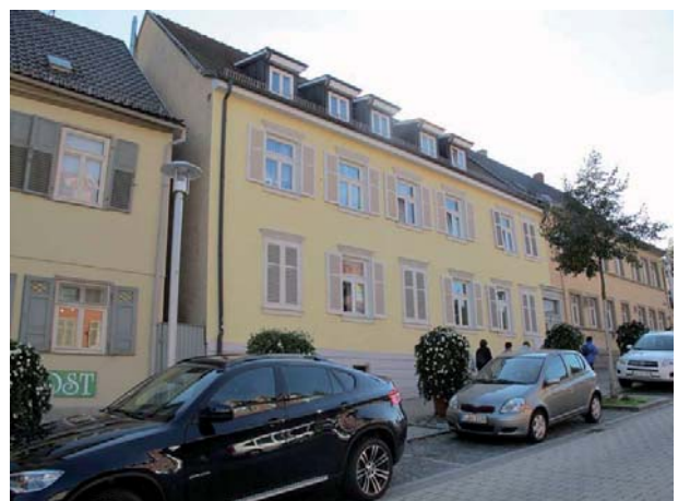
Ansicht des Mehrfamilienhauses von Nordosten
