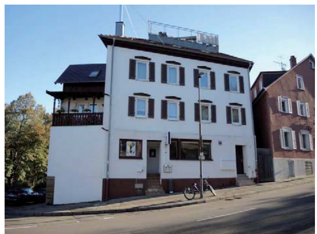
Ansicht des Wohn- und Geschäftshauses von Westen
