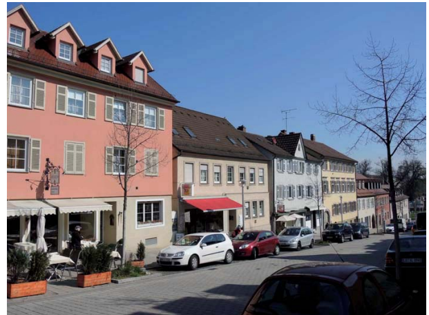
❶ Blick nach Nordosten auf Höhe von Hausnr. 4
