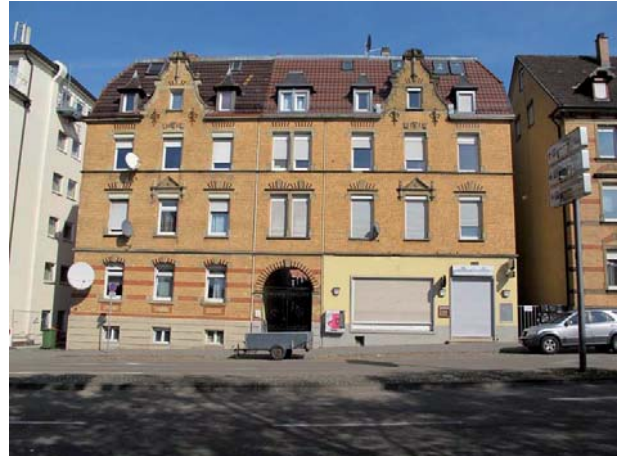
Ansicht des Mehrfamilienhauses von Südwesten
