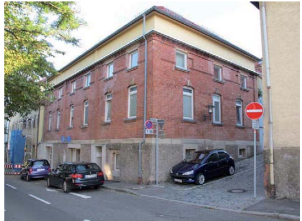
Ansicht des Wohn- und Geschäftshauses von Nordwesten
