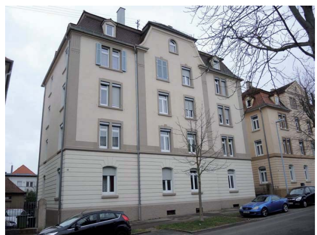
Ansicht des Mehrfamilienhauses von Nordwesten
