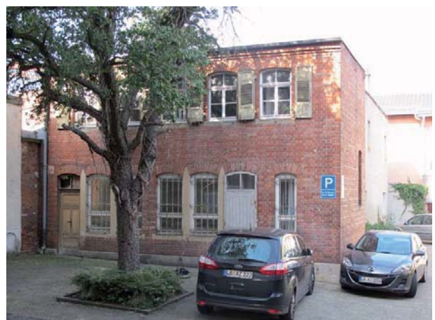
Ansicht des Nebengebäudes von Südosten
