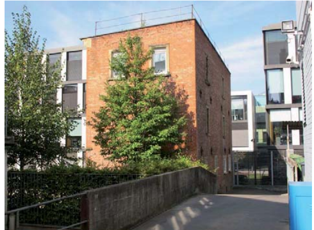
Ansicht des Nebengebäudes von Südosten
