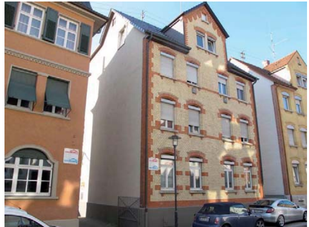
Ansicht des Mehrfamilienhauses von Südosten
