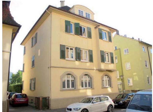
Ansicht des Mehrfamilienhauses von Nordosten
