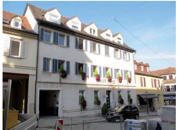
Ansicht des Gebäudes von Südwesten
