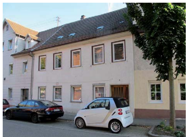
Ansicht des Wohnhauses von Nordwesten
