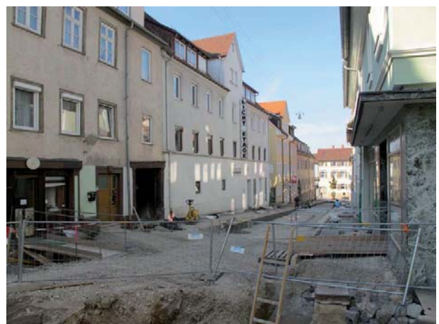
❶ Blick nach Norden auf Höhe der Alten Gasse
