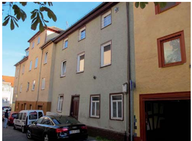
Ansicht des Wohnhauses von Nordwesten
