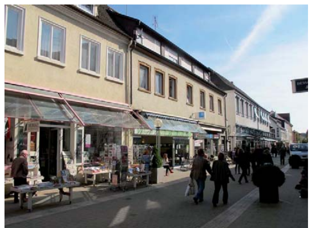
Ansicht des Wohn- und Geschäftshauses von Nordwesten
