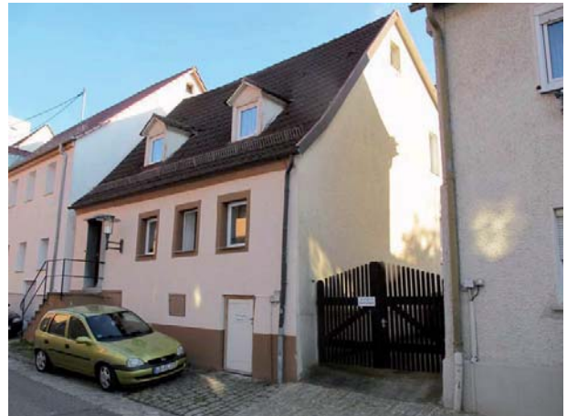
Ansicht des Wohnhauses von Nordwesten
