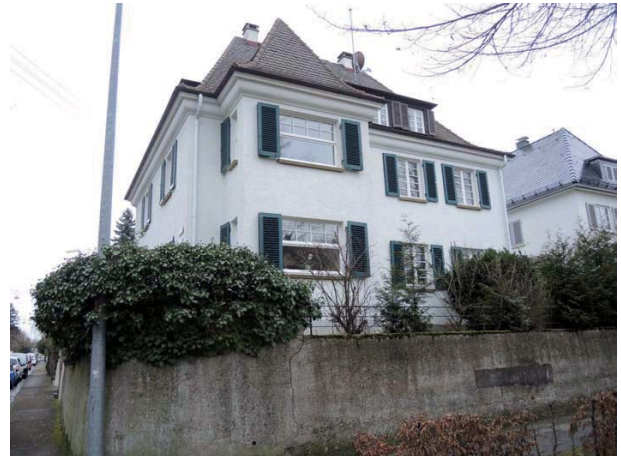
Ansicht des Wohnhauses von Nordwesten
