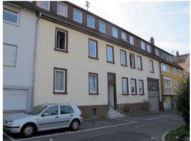
Ansicht des Mehrfamilienhauses von Nordosten
