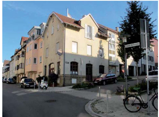
Ansicht des Wohn- und Geschäftshauses von Nordwesten
