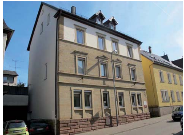
Ansicht des Mehrfamilienhauses von Nordwesten
