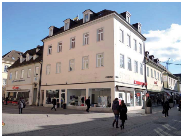
Ansicht des Wohn- und Geschäftshauses von Nordwesten
