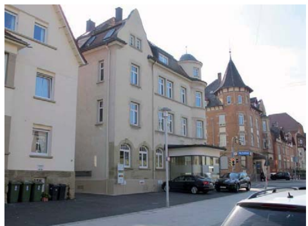
Ansicht des Mehrfamilienhauses von Nordosten
