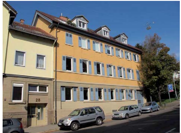
Ansicht des Mehrfamilienhauses von Südwesten
