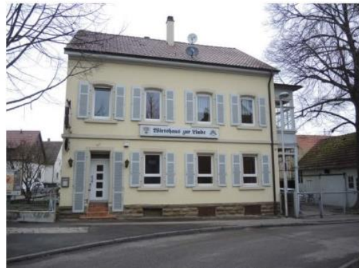
Ansicht des Gasthauses von Süden
