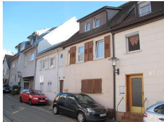
Ansicht des Doppelwohnhauses von Nordwesten
