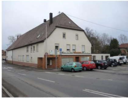
Ansicht des Wohn- und Geschäftshauses von Nordwesten
