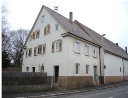
Ansicht des Wohnhauses von Nordosten
