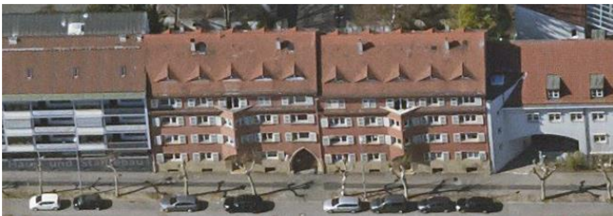
Gebäude Hohenzollernstraße 8-10, Luftbild: Stadt Ludwigsburg (2019)
