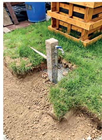
Steinstelen stützen die neuen Wasseranschlüsse.
