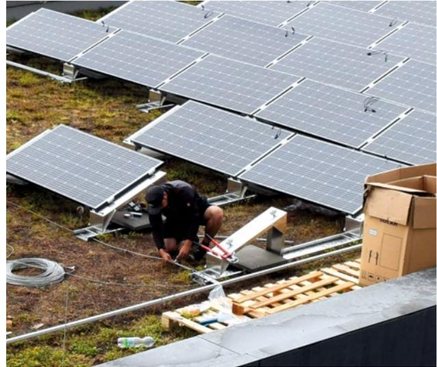
Abbildung 7: Montage einer PV-Anlage auf ein bestehendes Gründach.
