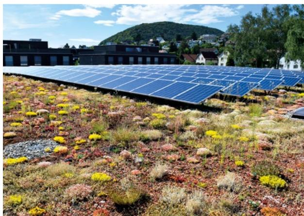
Abbildung 4: Extensive Dachbegrünung in Kombination mit PV-Anlage.
