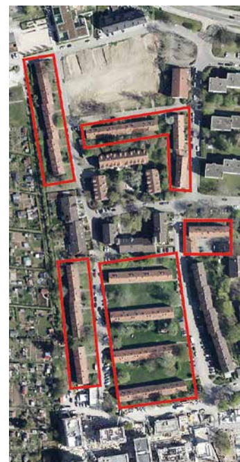
Die rot markierten Areale werden in den nächsten Jahren noch abgebrochen und neu bebaut. (Foto: Stadt LB)
