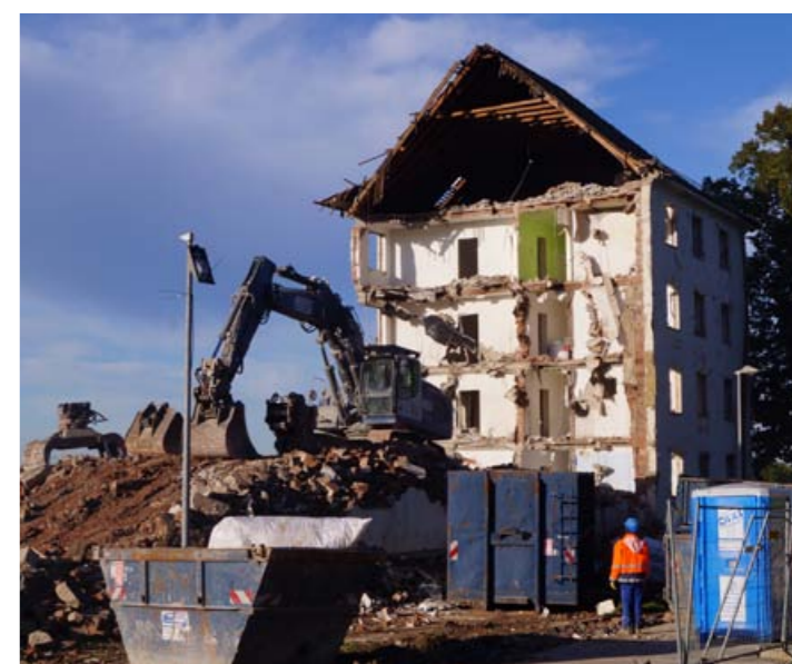
Mit dem Abriss der Flüchtlingsunterkunft sind die Abbrucharbeiten am Sonnenberg beendet. (Foto: Stadt Ludwigsburg)
