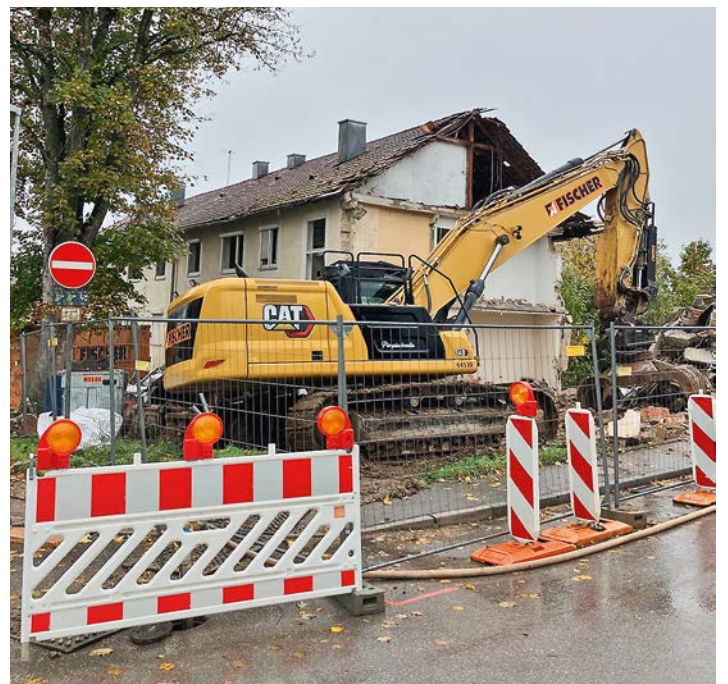
Der Abriss des Wohnblocks in der Elbestraße ist schon fortgeschritten. (Foto: Stadt Ludwigsburg)
