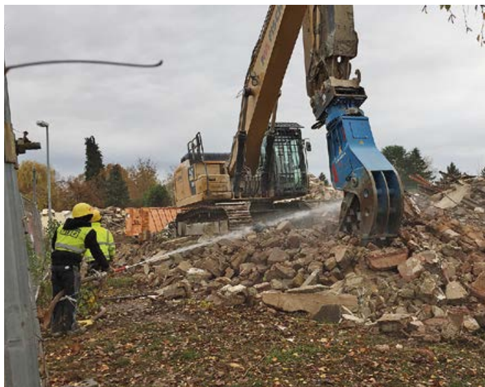
In der Neißestraße haben die Bagger schon ganze Arbeit geleistet. (Foto: Stadt Ludwigsburg)
